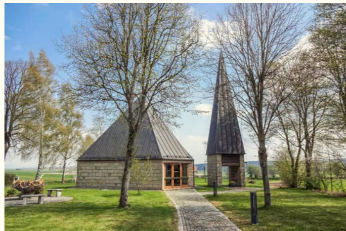
Cappella di Hatzenreuth Anno di costruzione: 1962/63 Consacrata l'8 settembre 1963 da Dominik Prokop, abate di Rohr
